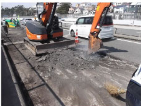
舗装撤去状況
